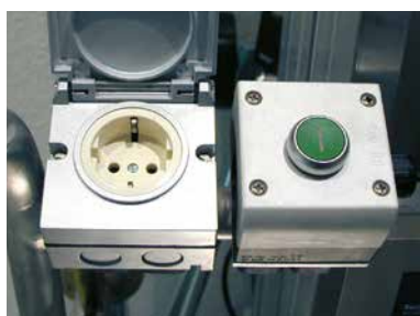
Stromversorgung im Arbeitskorb
