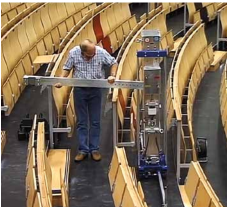
Installation der horizontalen Ausleger
